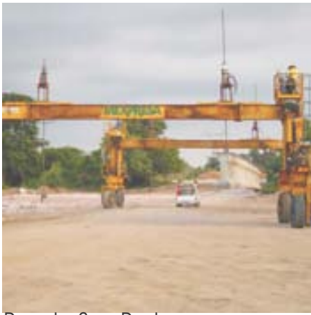
Puente San Pedro Carr. Tepic-Villa Unión, Nayarit
