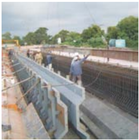
Puente San Pedro Carr. Tepic-Villa Unión, Nayarit
