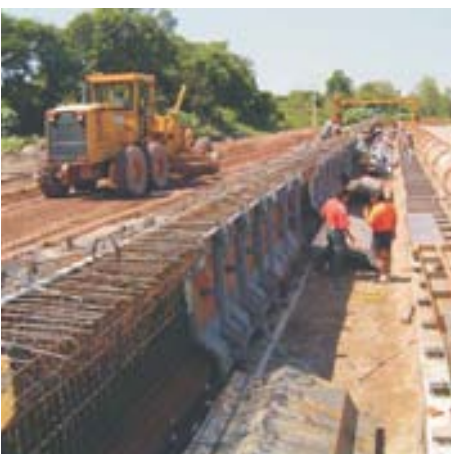
Puente San Pedro Carr. Tepic-Villa Unión, Nayarit
