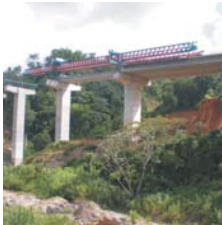
Puente Utuado-Adjuntas San Juan, Puerto Rico
