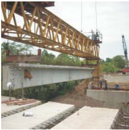
Puente Muhuan Nicaragua
