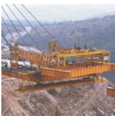
Puente Barranca el Cañon Aut. México-Acapulco
