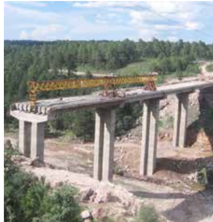
Puente Arroyo Coyotes Carr. Durango-Mazatlán
