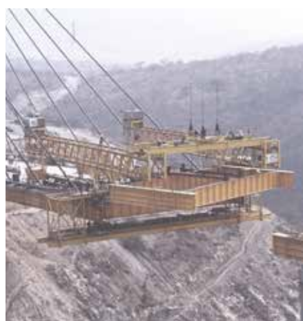
Puente Barranca el Cañon Aut. México-Acapulco
