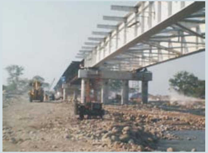
Martínez de la Torre Bridge, Mexico
