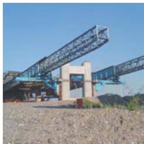
Puente Albatros Lázaro Cárdenas, Michoacán
