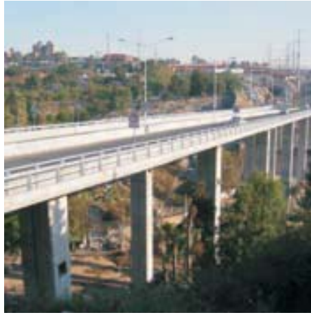
Puente Vehicular Tarango Eje 5 Poniente, D.F.
