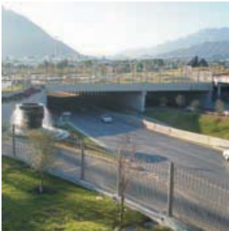
Puente Gran Canal Monterrey, N.L.
